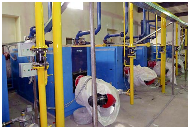
Монтаж котельной с горелками WM G 20/2 и WM-GL 20/2-A
